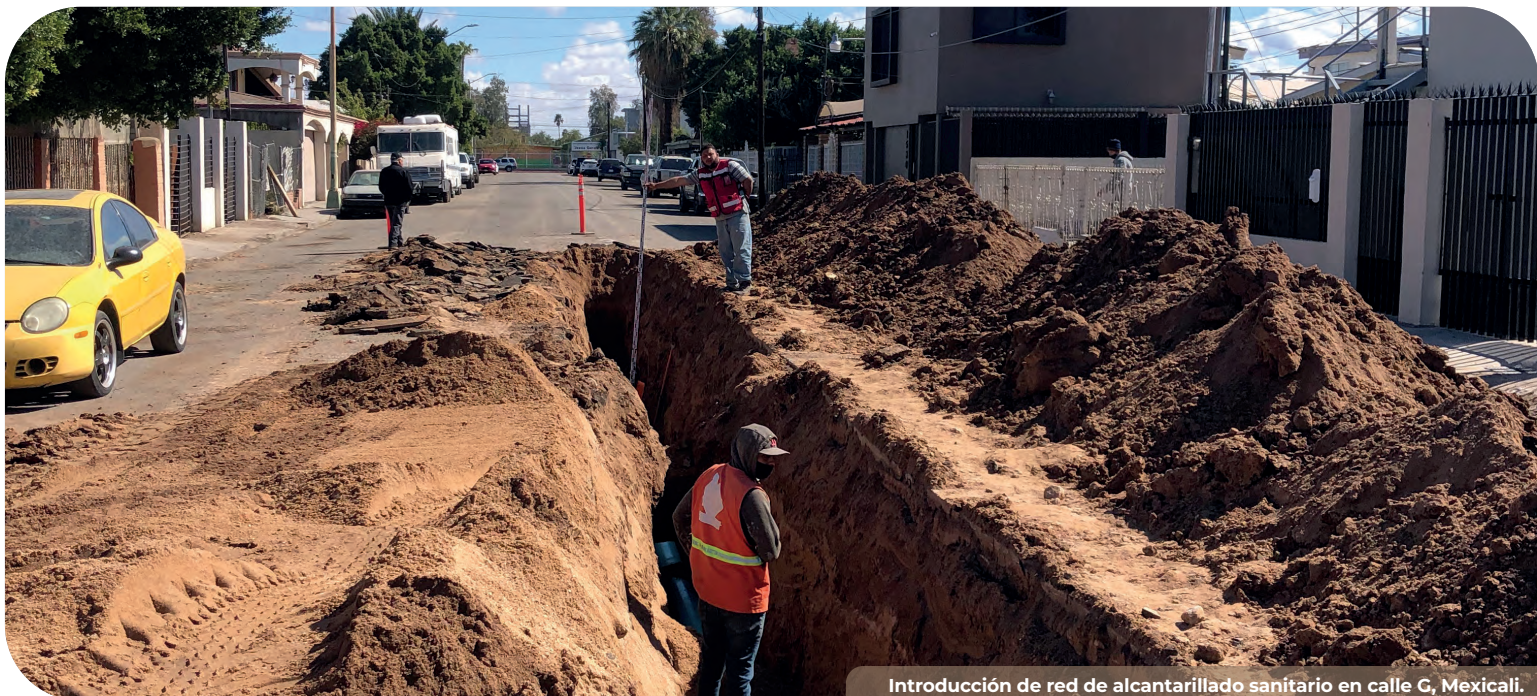
Introducción de red de alcantarillado sanitario en calle G, Mexicali.
