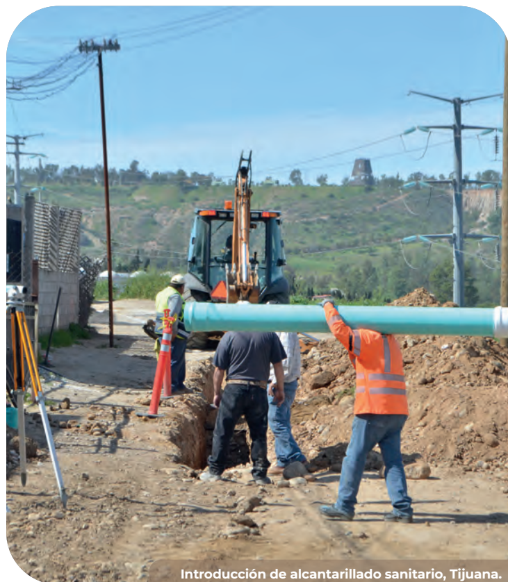
Introducción de alcantarillado sanitario, Tijuana.
